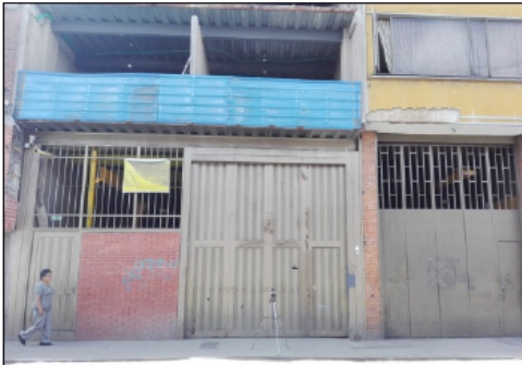
Foto No. 1 Punto de Medición
